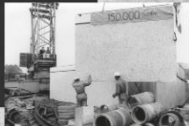
Plaatsen betonplaat flats Van Veldekestraat 1969
