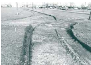
Aanleg fietspad Paganinistraat
